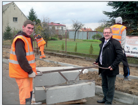
Starosta Pleszewski Michał Karalus z wizytacją na budowie ul. Podgórznej
