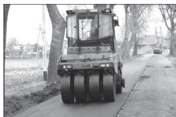
Lenartowice – remont 400 mb drogi powiatowej
