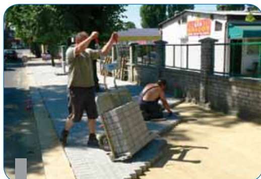
Układanie chodnika przy ul. Ogrodowej w Pleszewie
