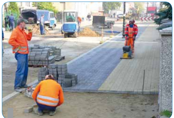
Prace przy budowie nowego chodnika przy ul. Poznańskiej w Pleszewie
