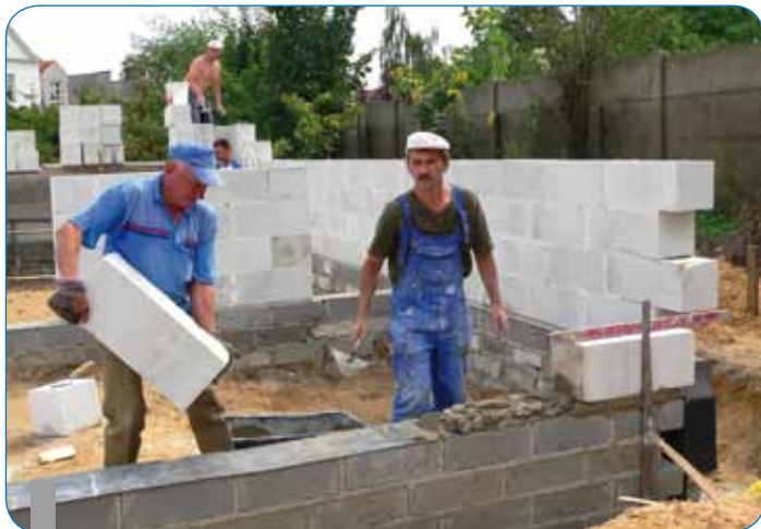
Roboty murarskie przy rozbudowie CKP (2009 r.)
