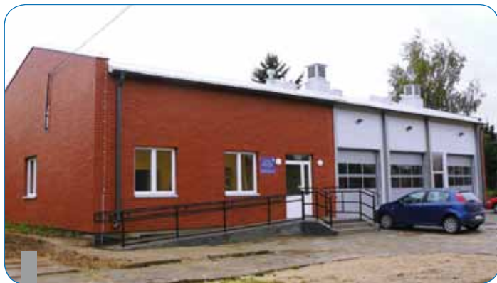
Nowy budynek administracyjno-warsztatowy CKP (2010 r.)
