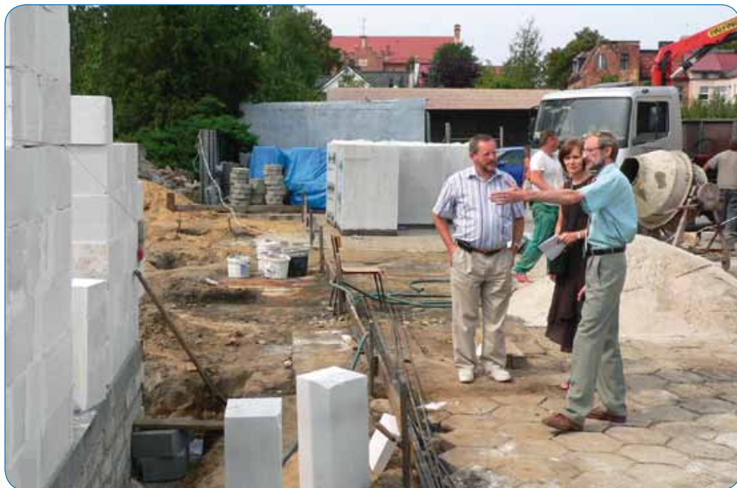
Starosta Pleszewski M. Karalus i naczelnik Wydziału Inwestycji, Strategii i Rozwoju D. Witczak podczas wizytacji rozbudowy Centrum Kształcenia Praktycznego w obecności dyrektora R. Paruszewskiego (2009 r.)
