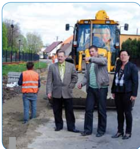
Wizytacja inwestycji drogowych powiatu w sierpniu 2010 r. (Kowalew)
