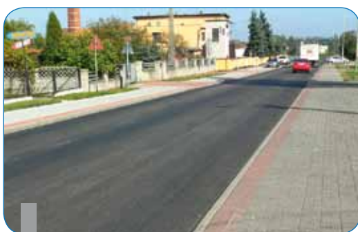
Zmodernizowany odcinek drogi Pleszew - Dobrzyca (Kowalew)
