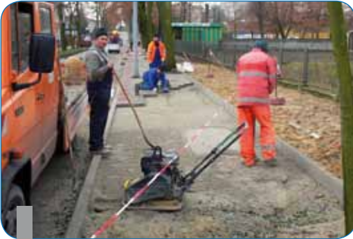
Układanie chodnika przy ul. Podgórznej w Pleszewie
