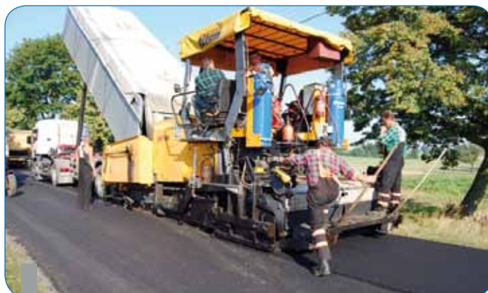
Modernizacja drogi Bronów – Krzywosądzów (Borucin)
