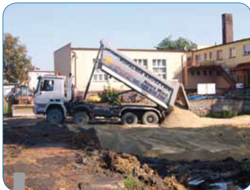
Budowa kompleksu boisk sportowych „Orlik” przy ul. Hallera (2010 r.)
