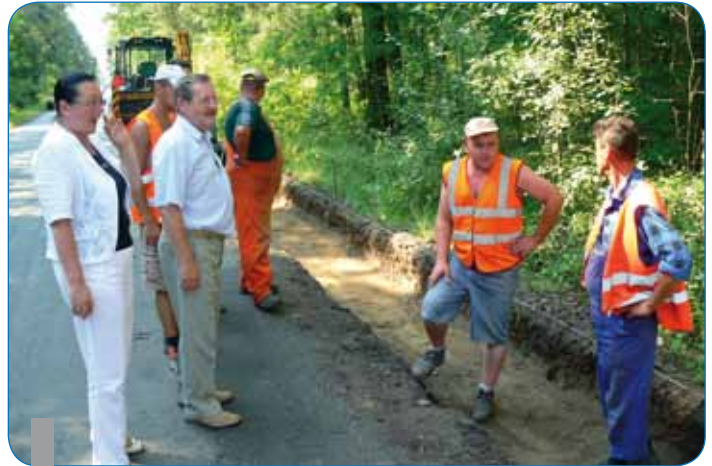
Poszerzanie drogi powiatowej Grab – Czermin (Pieruszyce)
