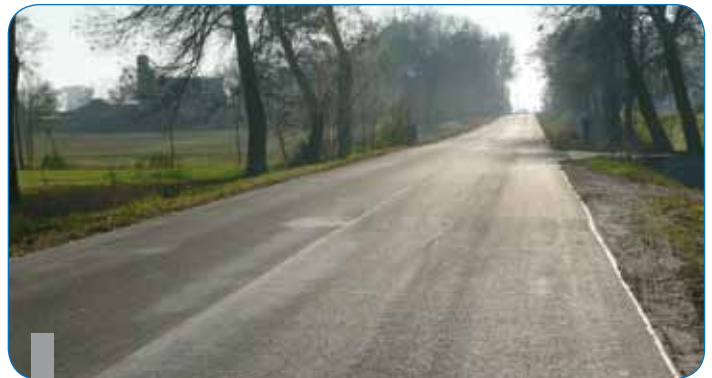
Przebudowana droga Pleszew – Taczanów (Sowina)
