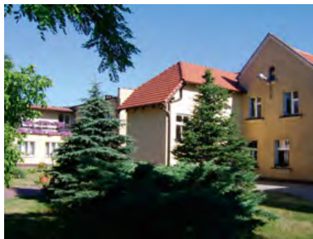
Zdj. 4. Budynek przy ul. Malińskiej 9
