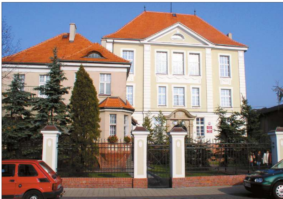
I Liceum Ogólnokształcące im. St. Staszica przy ul. Poznańskiej w Pleszewie po renowacji
