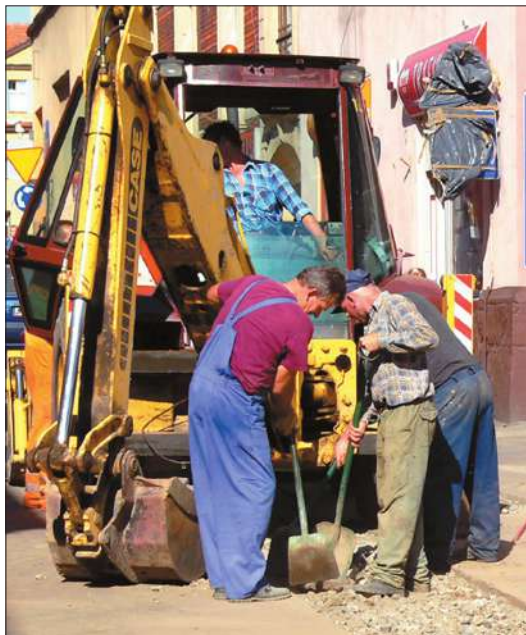
Prace remontowe na ul. Sienkiewicza w Pleszewie
