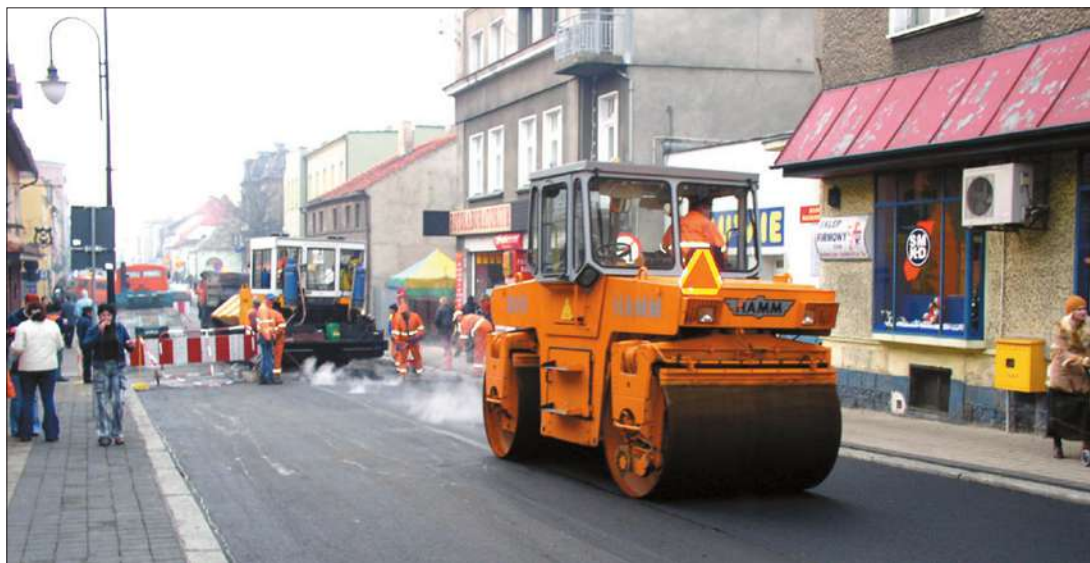
Nowa nakładka asfaltowa na ul. Poznańskiej w Pleszewie
