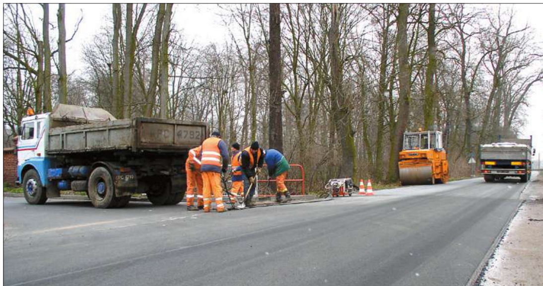
Modernizacja ul. Ostrowskiej w Dobrzycy
