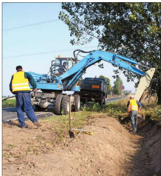
Przebudowa drogi od miejscowości Dobrzyca - Nowy Świat do granicy z Powiatem Krotoszyńskim wraz z pogłębieniem rowów przydrożnych
