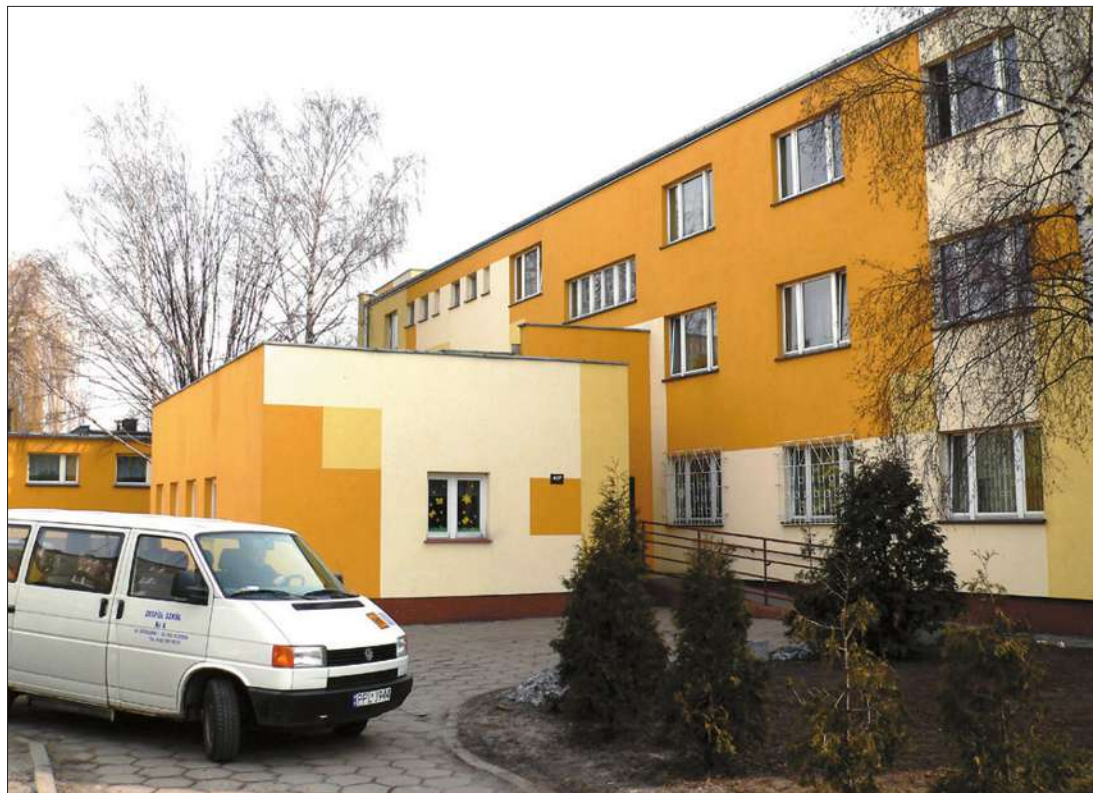
Zespół Szkół Specjalnych przy ul. Zielonej po termomodernizacji
