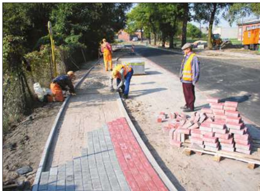
Budowa zatoczki autobusowej w Brzeziu (gm. Pleszew)
