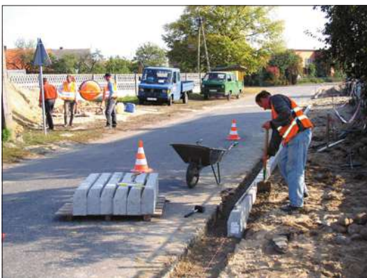
Budowa chodnika w Galewie (gm. Dobrzyca)
