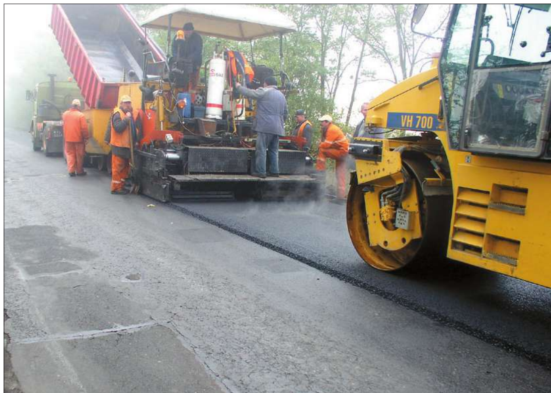
Modernizacja drogi Pleszew-Chocz
