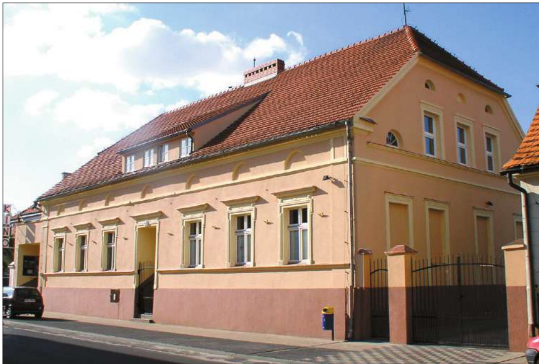
Wyremontowany budynek Zespołu Szkół Usługowo-Gospodarczych im. H. Cegielskiego przy ul. Poznańskiej
