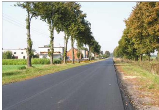
Zmodernizowana droga Brzezie – Janków (gm. Pleszew, gm. Gołuchów)
