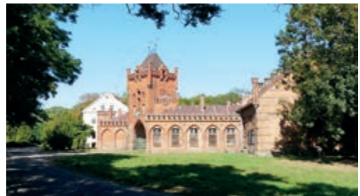
Wieża wjazdowa, Taczanów, IX 2018 (© Przemysław Żurawlew)
